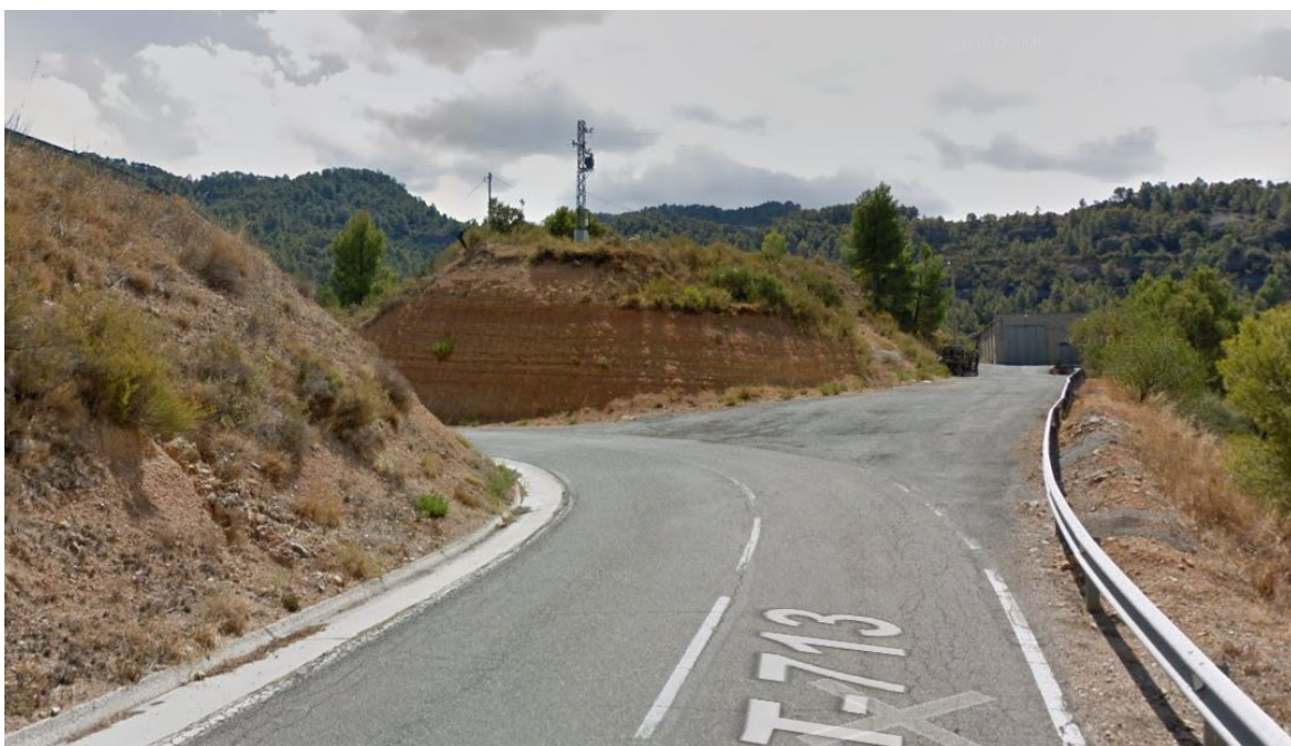
Figura 21 Vista del turó i de l'accés a la bassa, de la nau de la cooperativa i la torre de mitja tensió des de la carretera T-713, venint de la Bisbal de Falset. Foto Google Street.
