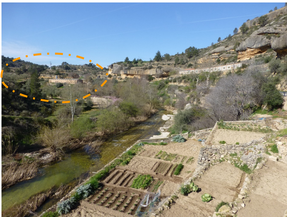
Figura 25 Vista de la granja i la torre MT des dels horts del poble a la carretera T-713, venint de Margalef.
